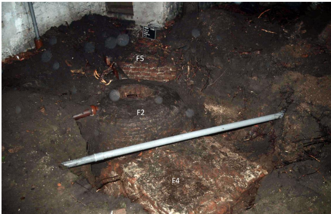
Afb. 10 Overzicht van een deel van de toren van de waterpoort F5 met de beerput F2 en eerste kolom van de stadsmuur F4.
